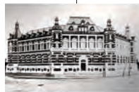
1899年 東京商業会議所ビル完成
